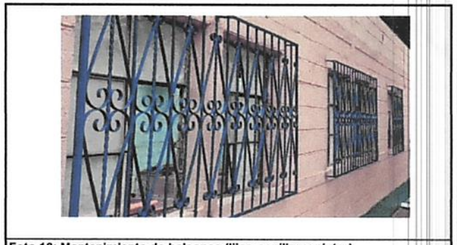
Foto 12: Mantenimiento de balcones (lijar, cepillar y pintar)
