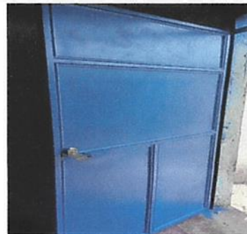
Foto 4: Cambio de chapas de puerta de metal
