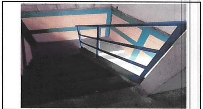
Foto 10: Instalación de baranda de metal
