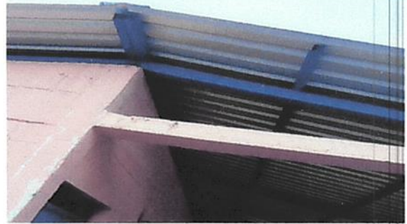
Foto 2: sustitución de capote de lamina troquelada
