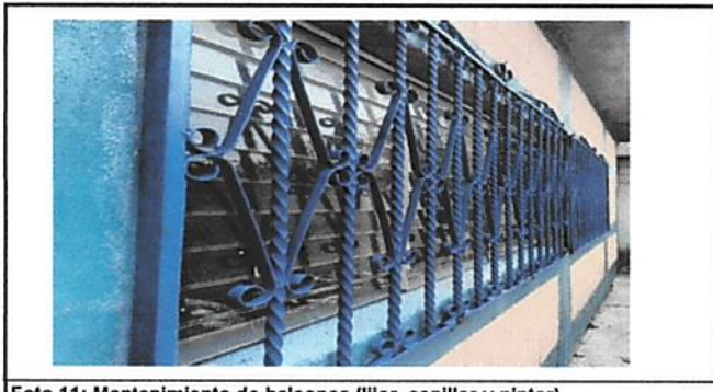
Foto 11: Mantenimiento de balcones (lijar, cepillar y pintar)
