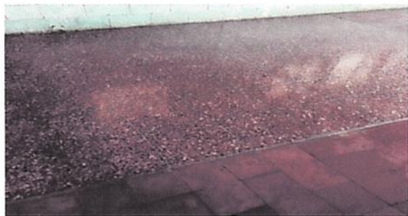
Foto 5: Instalación de piso de granito
